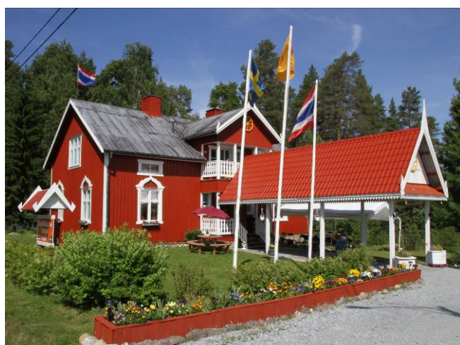
En västerbottensgård ombyggd i "thaistyle", Buddharama templet, Fredrika (foto: Tomas Forsberg)
