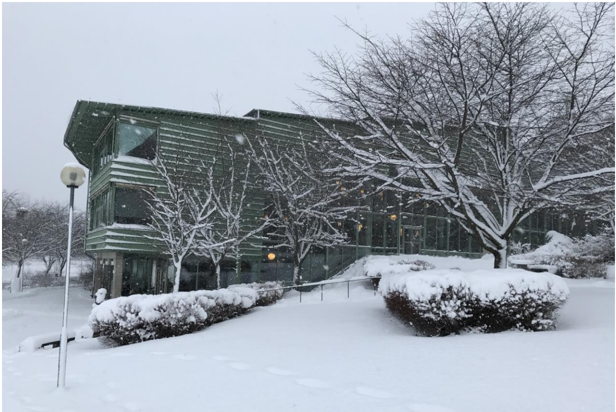
Geovetenskapens hus i Frescati.
