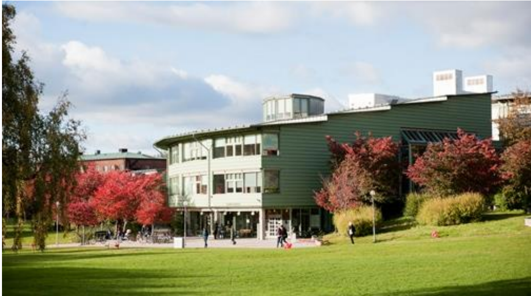
Geovetenskapens hus i Frescati.
